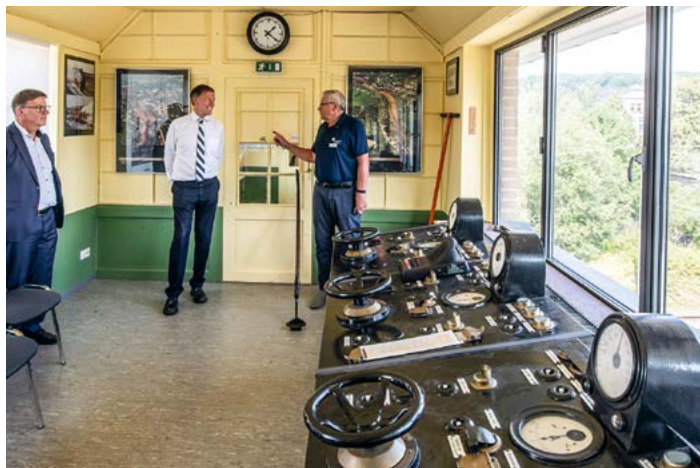
// Stellwerksgebäude von innen
