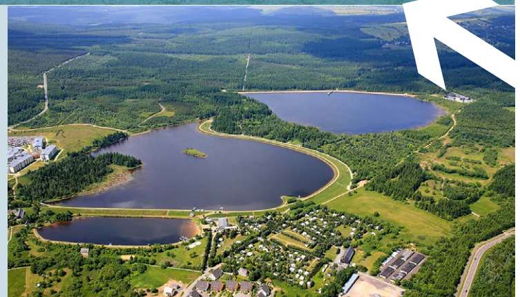
// Talsperrensystem Altenberg // Foto: Landestalsperrenverwaltung Sachsen / Foto-Co Peter Schubert
