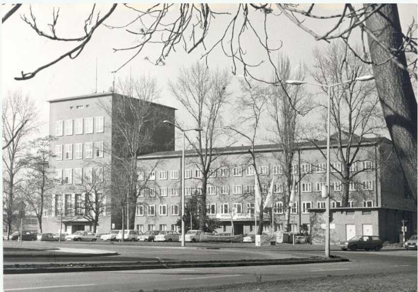
Das ehemalige Landesfinanzamt vor Rekonstruktion und Umgestaltung (Abschluss im Jahr 1997) Bild: Michael Dulig für Sächsischen Landtag
